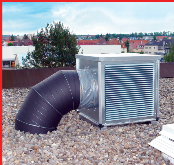
Montaż na dachu z daszkiem ochronnym i kratką wyrzutową (osprzęt)
