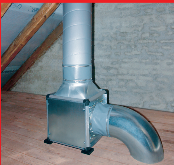
Montaż na poddaszu na wibroizolatorach SDD-U (osprzęt)
