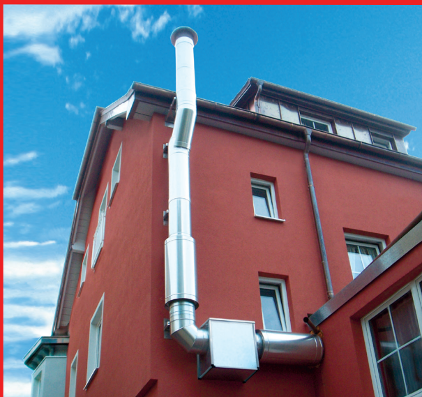
Montaż zewnętrzny na konsoli ściennej (osprzęt)
